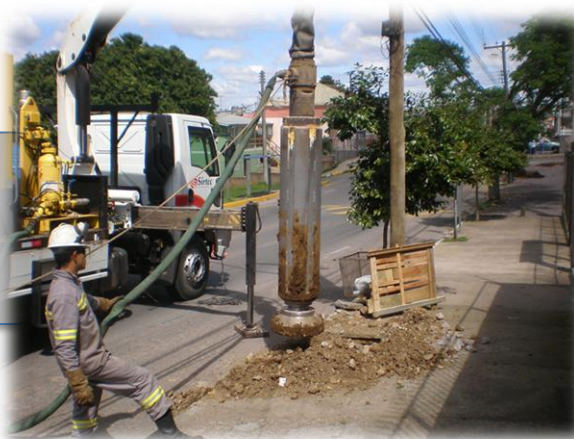
Abertura de cava em solo com rocha
