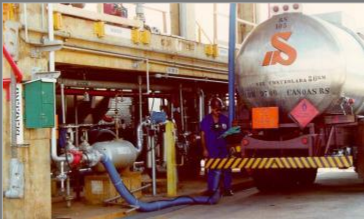
Estação para Caminhões
