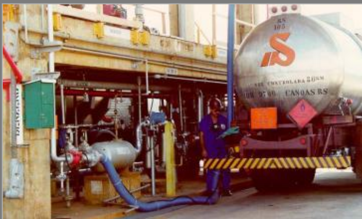
Estação para Caminhões
