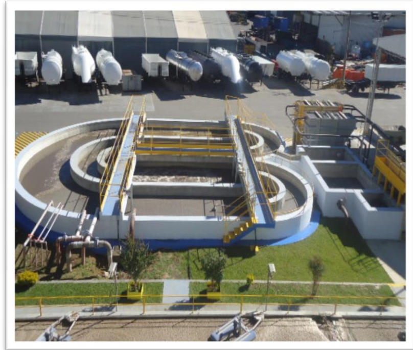
Estação de Tratamento de Efluente - ETE
