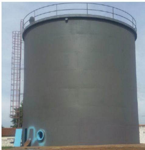
Reservatório em construção
